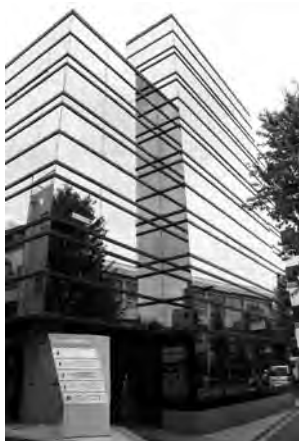
▲(株)日本レーザー東京本社
